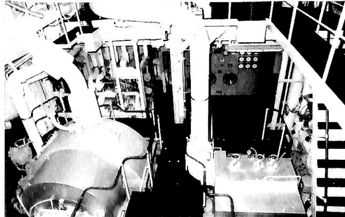
主機 タービン機関室
