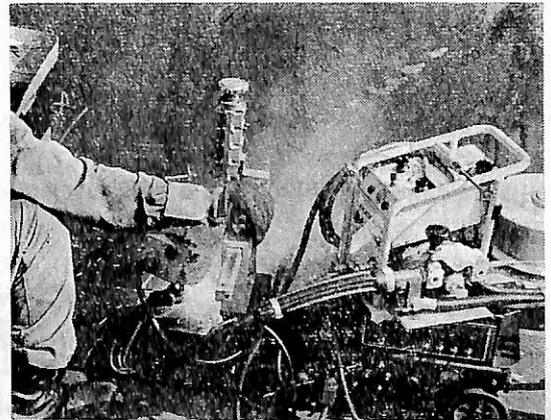
写真 17 V型横向自動溶接の適用状況
