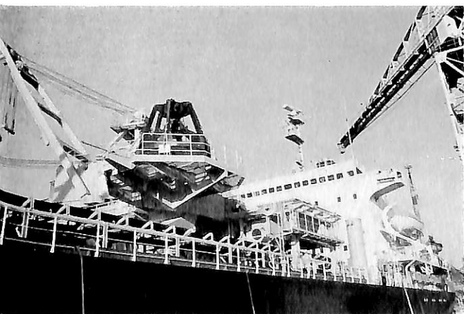
荷役装置 (船側より見る)
