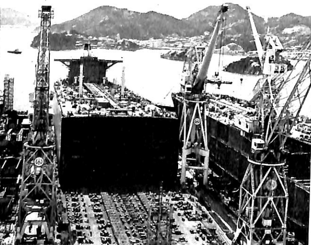
進水前の大光丸船尾部
