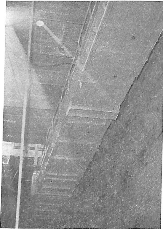
第29図 オーバベッドステージ架設の状況
