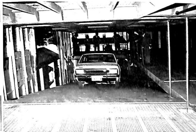
艀口前後部のリフトブル・デッキを傾斜路として利用
