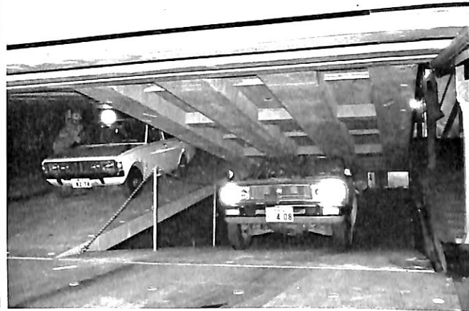
ボンツーン・デッキを傾斜路として利用
