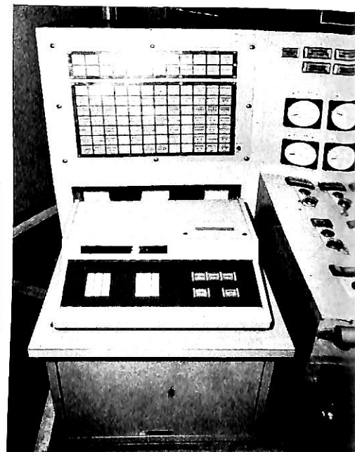
ボイラ・モニタリング標示盤
