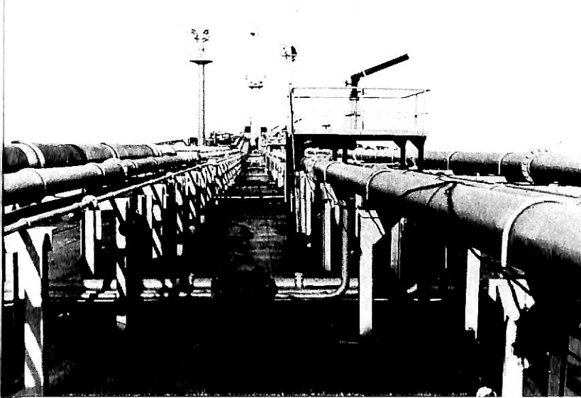
上甲板上の高架配管
