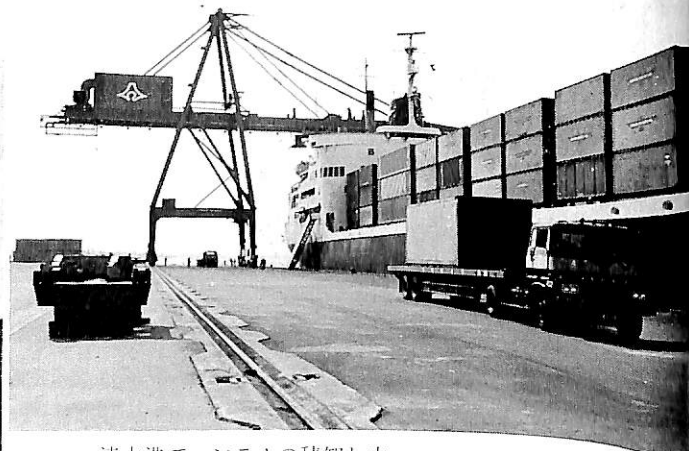
清水港でコンテナの積卸し中
