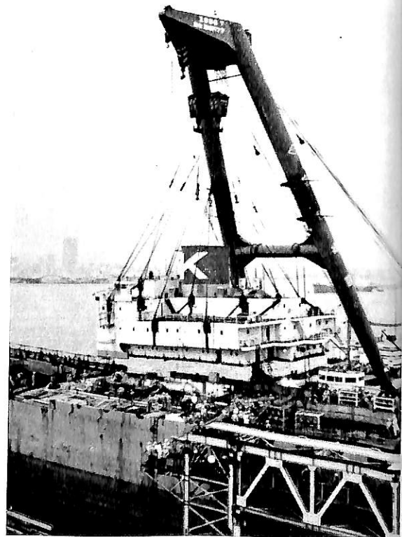
居住区撤去中(重量約400t)
