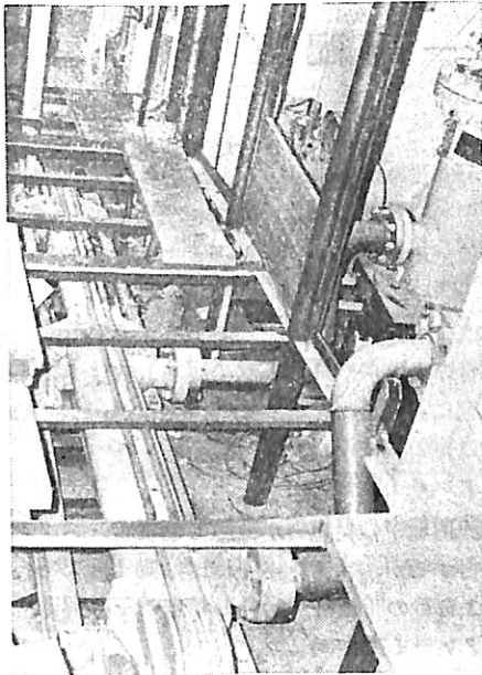
床下をとるワイヤと滑車 (右にオイルタンクとアキュムレータ)
