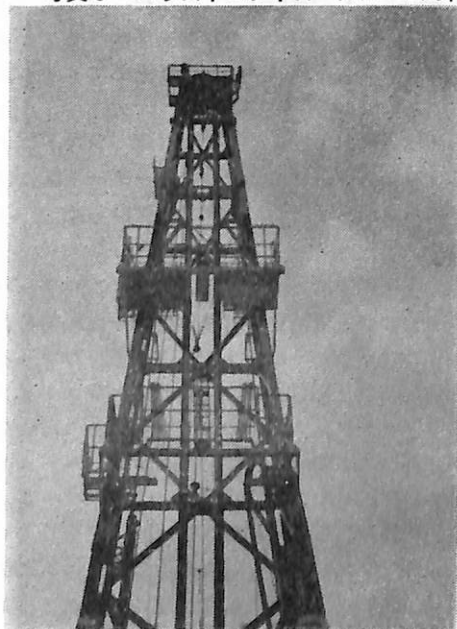
写真4 ドリリングマスト
