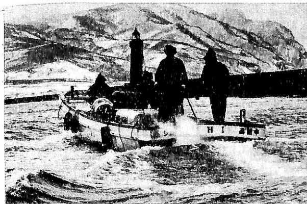
ハイドロ・ジェットを装備した漁船(左)と高速艇(右)
