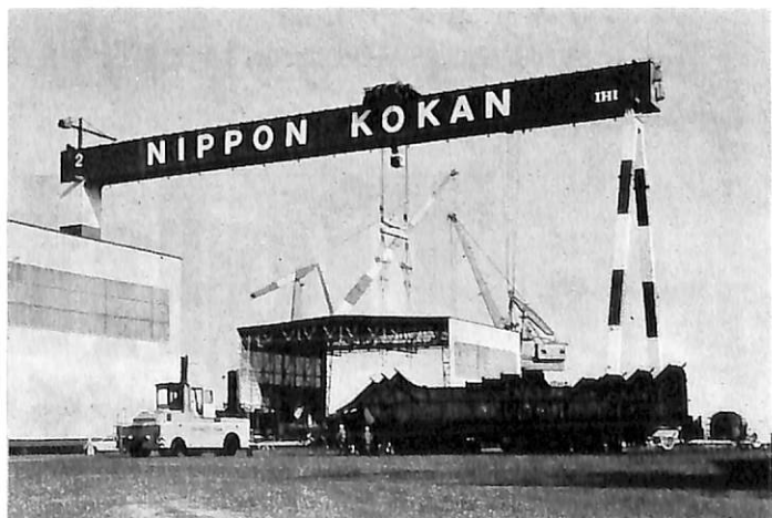
大ブロックをドック脇へ運搬中の360トントレーラー
