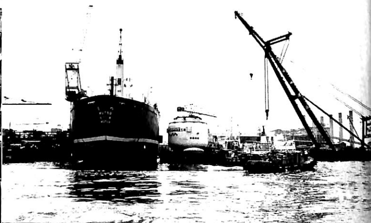
③ 予定通り9時30分東京第2工場に到着し、むつの舷側に接舷する。これより海上クレーン船（海上丸）のクレーン（吊上力量400t）による搭載作業が始まる。
