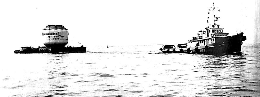
① 1,000 t 積み大型バージ（L32.9m、B13.4m、D3.2m）に搭載し、東京湾羽田沖を東京に向う。横浜発午前4時。
