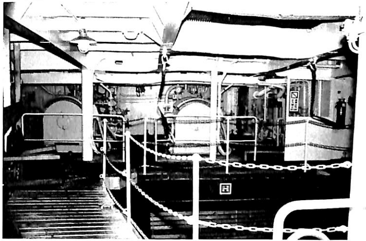
船舶およびケーブル エンジンポンプ室
