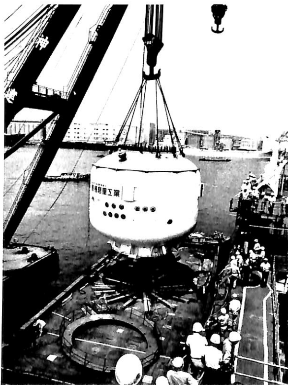
④ 10時25分、吊上索をかけ終り、バージ上より吊上げる
