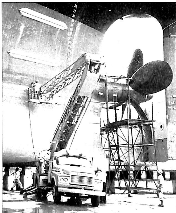
船体へ塗装作業中の高所空中作業車
