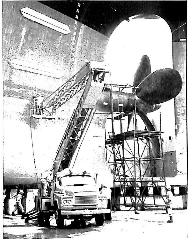
船体へ塗装作業中の高所空中作業車
