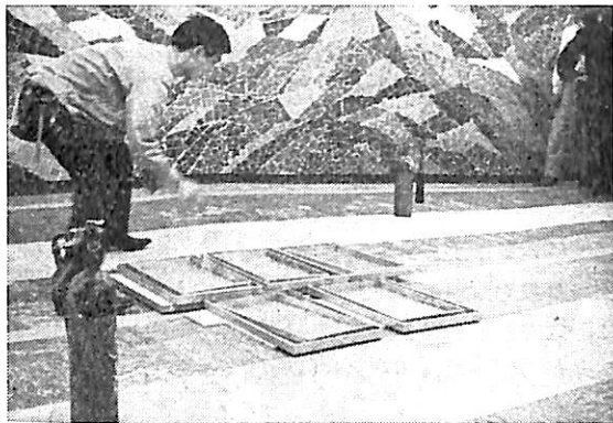
写真 6.9 空気管式火災警報装置のテスト
