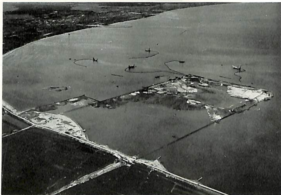
日本鋼管・津造船所埋立工事
