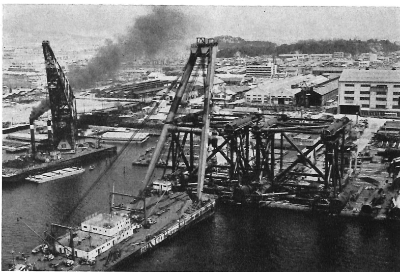
広島造船所にて建造中の4脚ドルフィン2基
