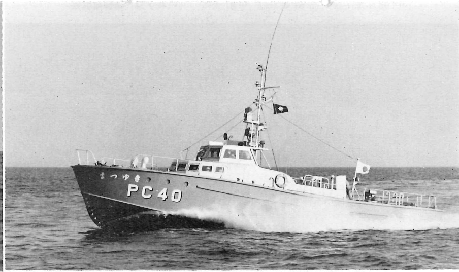
巡視艇 まつゆき 全長 21 m 排水量 39 t 最大速力 27 kn
