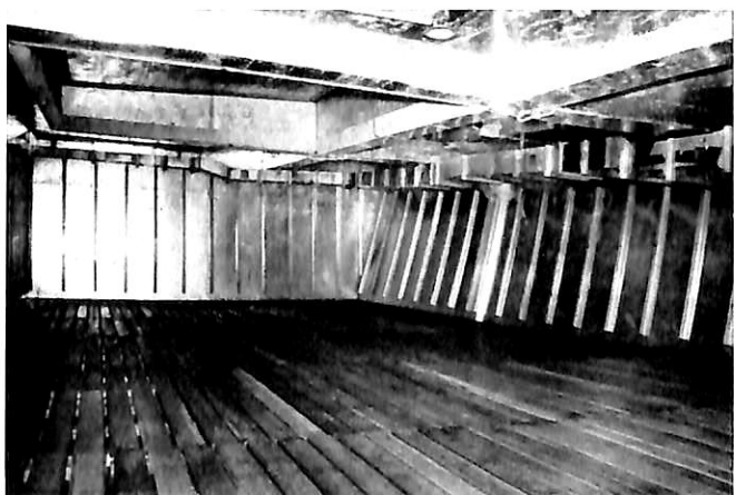
冷蔵貨物艙内部
