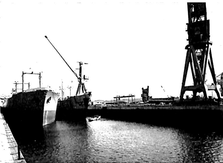
第1期工事完成し修理工事を開始した修理ドック
