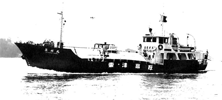
液化アンモニヤタンカー 泉州丸 日新運輸倉庫株式会社 SENSHU MARU
