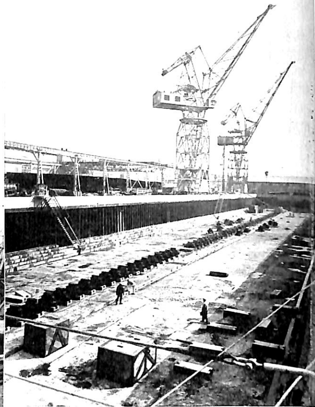
完成した25,000トンビルディングドック
