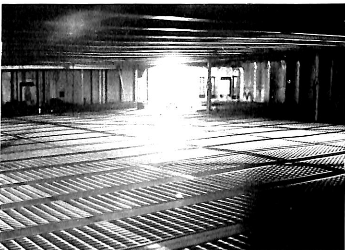
グレーティングを敷きつめた自動車格納甲板
