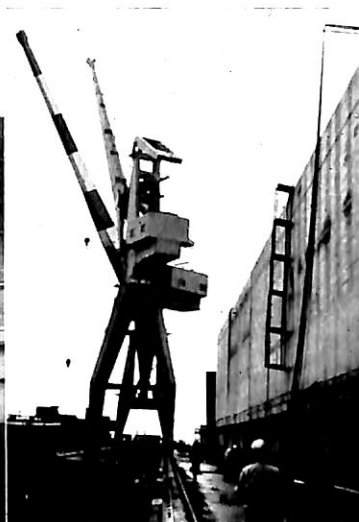
左舷外板は壁のごとくそそりたつ。30tジブクレーンの左側は大組立ブロック置場。
