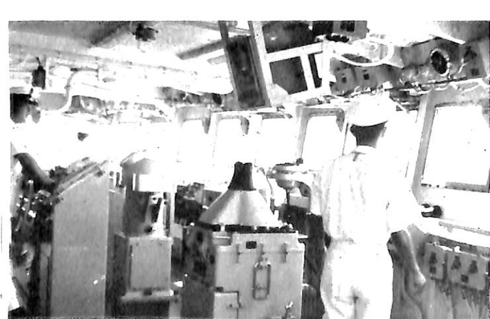
艦橋操舵室内部
