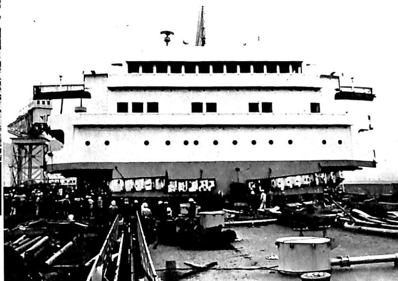
ブリッジ移設工事。両船体はロープで結合してあるだけ。(40-3-2)
