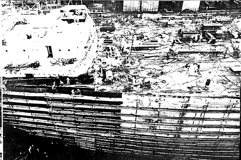
完成近い結合工事 (40-2-21)
