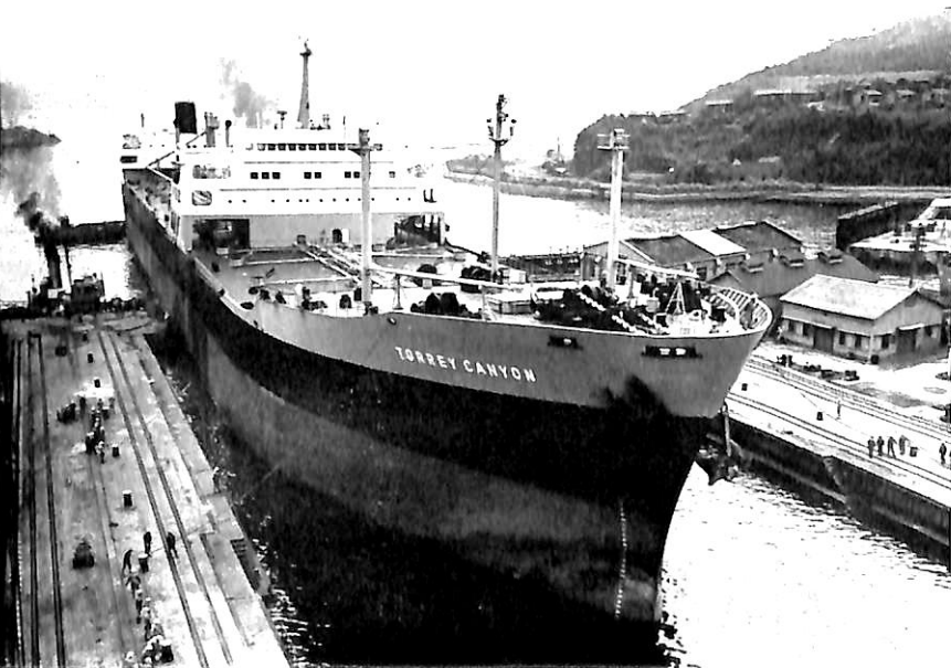
旧船体を切断するため入渠
