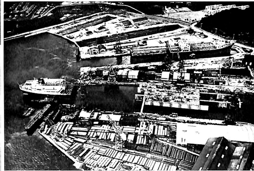
旧船尾部を新船体部建造中の4ドックへ入れるところ。 (上の船首部は旧船体) (39-12-18)
