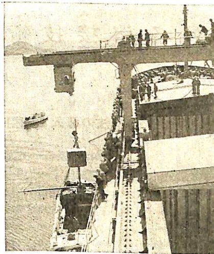
写真1 橋型クレーンによる荷役状況
