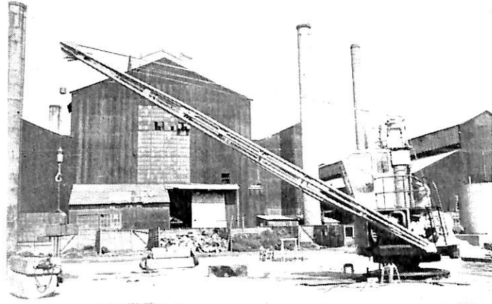
藤永田造船所で製作試験中の第1号機3tデッキクレーン
