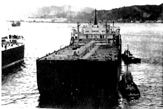
写真7 ↑ 旧船尾部をドックに残し 写真8 ↓ 旧船体前部は出渠させる。
