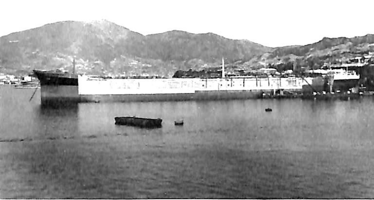
写真13 結合して出渠した新船体
