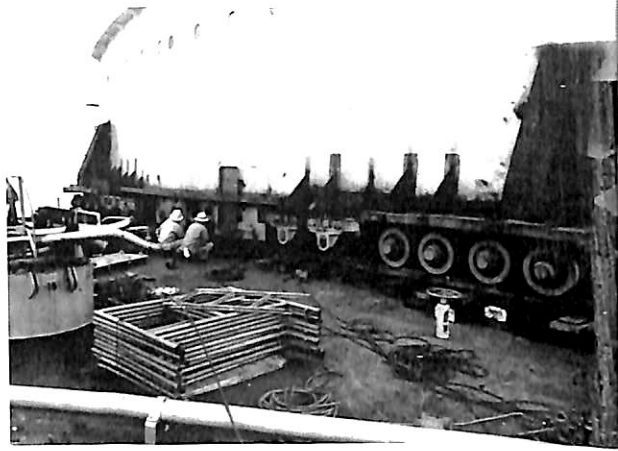
写真14 船橋移設用レール敷設
