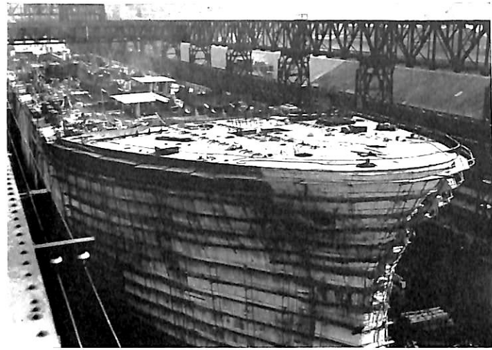
写真12 新旧船体結合終了し出渠を待つ
