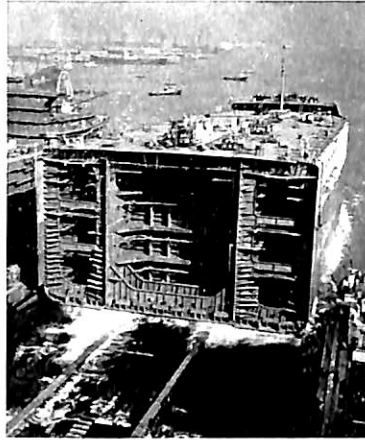
船首部の進水 (40-1-22)
