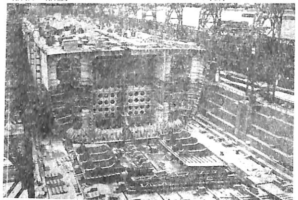
完成した新船体部
