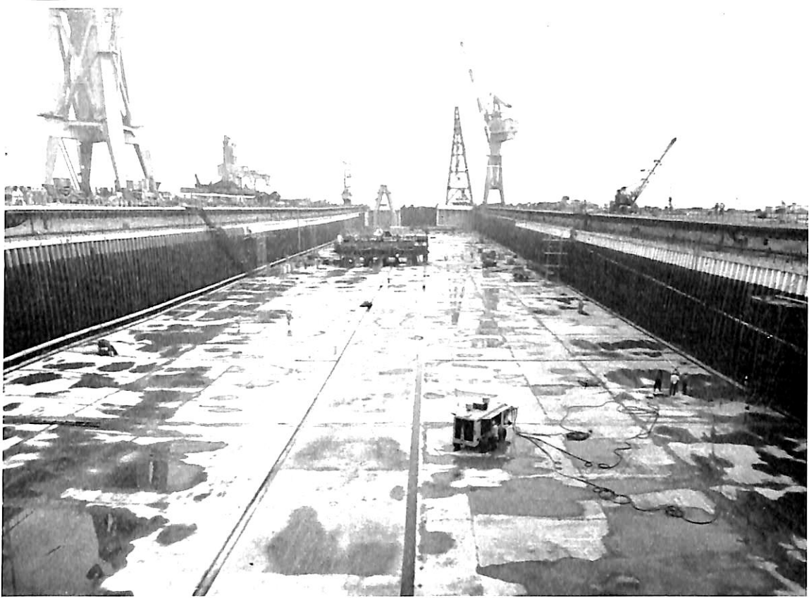
石川島播磨・横浜第二工場16万トン建造ドック
