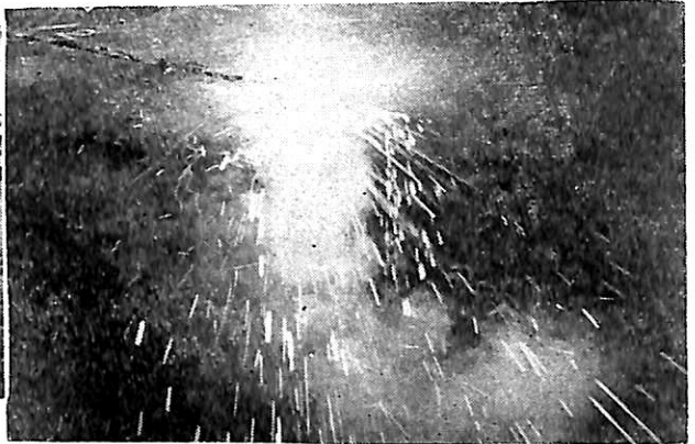
第 7 図 裏波溶接を裏面より見た状況（アークの左側裏波完成）
