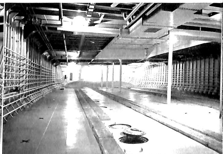
ブルドーザー格納艙内部 (8台収容)
