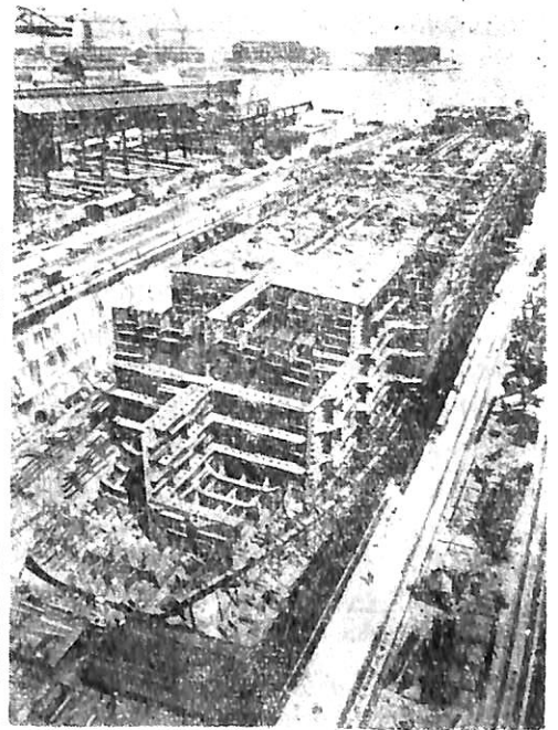
1-17図 戦後日本の造船所のかげやかなしい記録の象徴ともいえる世界最大のタンカー、日章丸を佐世保重工にて建造中の状況（昭和37年完成）。
