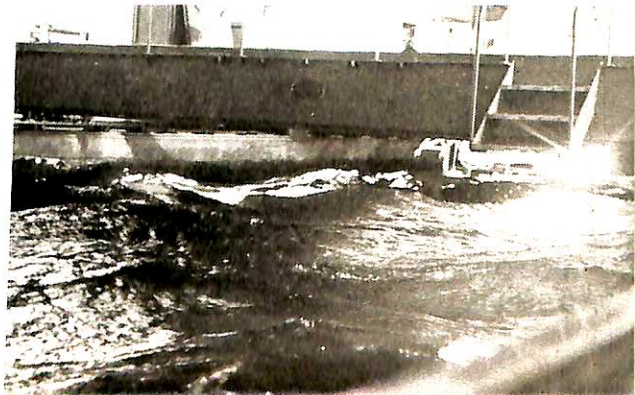
写真 8 5 節波送風試験
