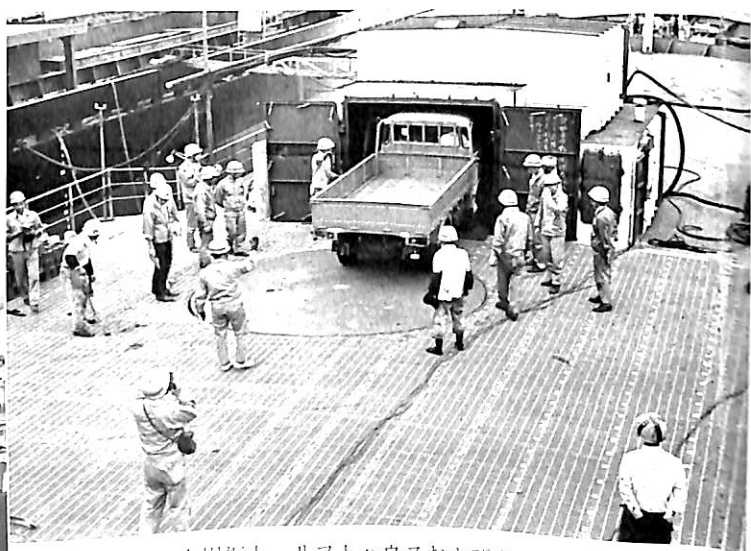
上甲板上 リフトハウスおよびターンテーブル
