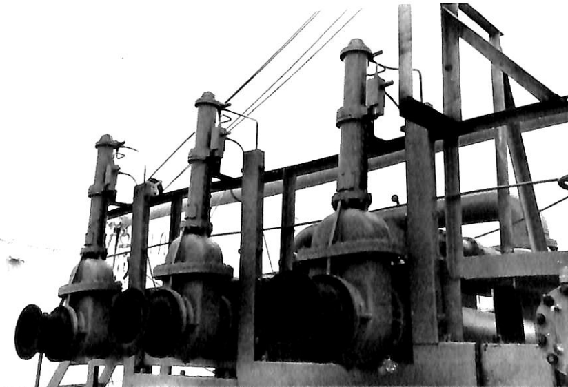
油圧シリンダ式遠隔仕切弁
