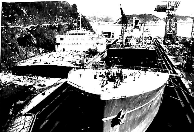
③ 船首上甲板部陸上預け工事
