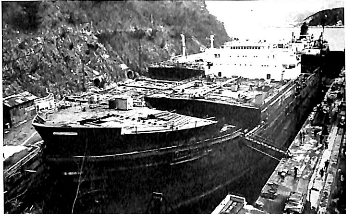
⑨ 船首上甲板部受取り工事
