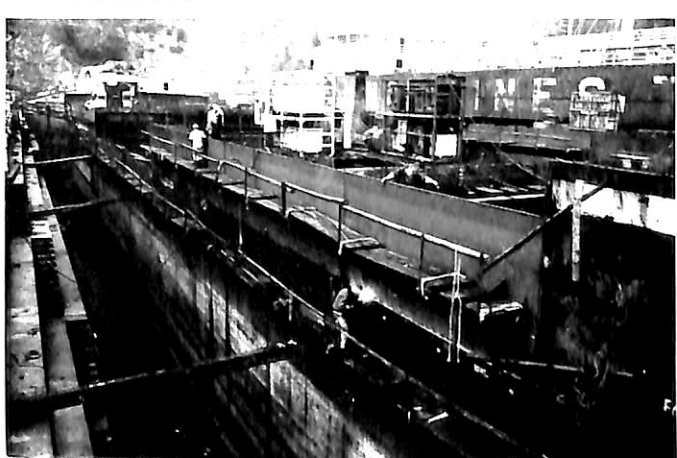
⑦ 増深新設部工事
