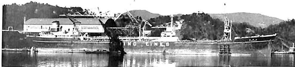
① 改造前 入渠準備工事中
