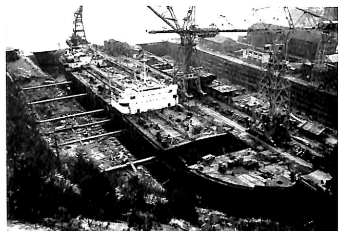
⑩ 上甲板部受取り工事完了
