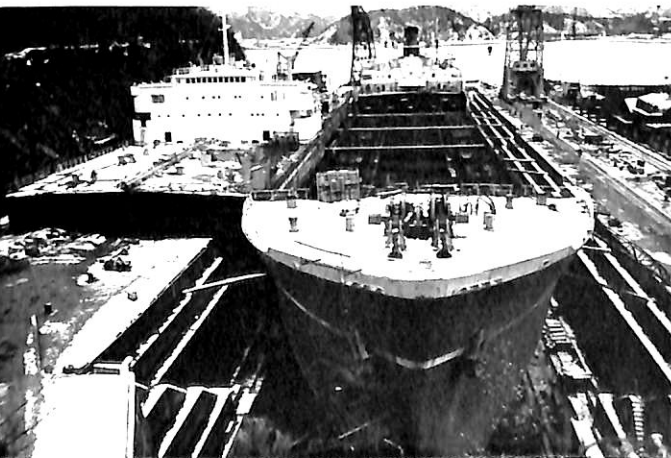
④ 陸上預け工事完了
