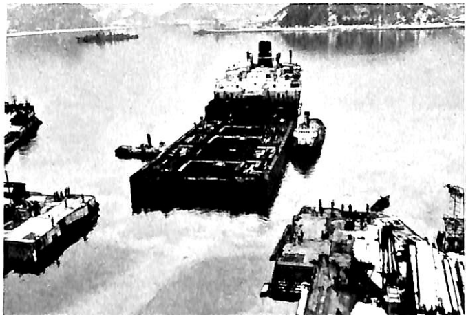
⑥ 高盤木撤去のための出渠
