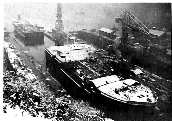
⑫ 三船体接合工事
