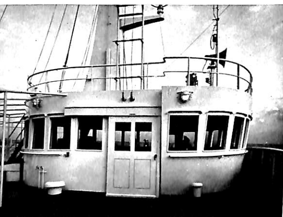
円型操舵室外観（右舷側）
