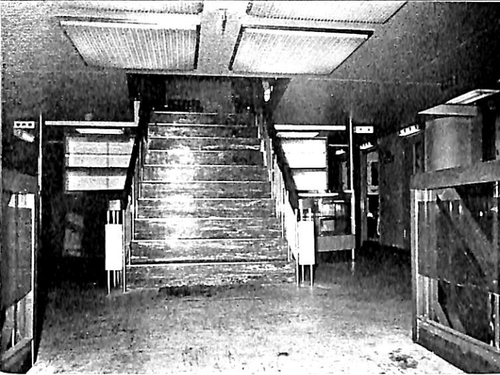
前部エントランスおよび階段 階段の右は売店、左は案内所
