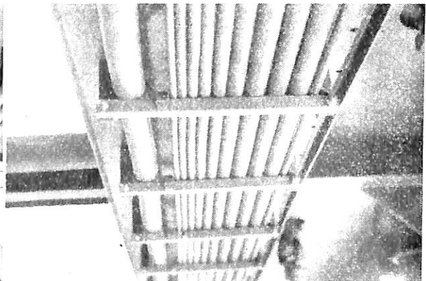
露天部の例（作業甲板下、電線通路カバーを外したところ）
