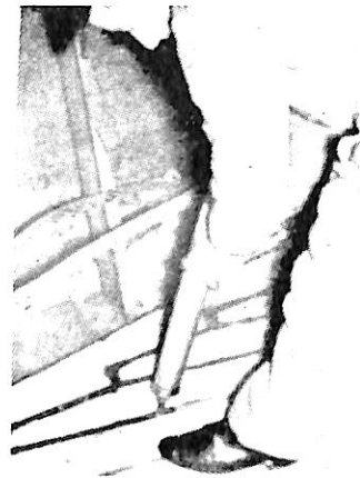
木甲板のコーキングに使用
