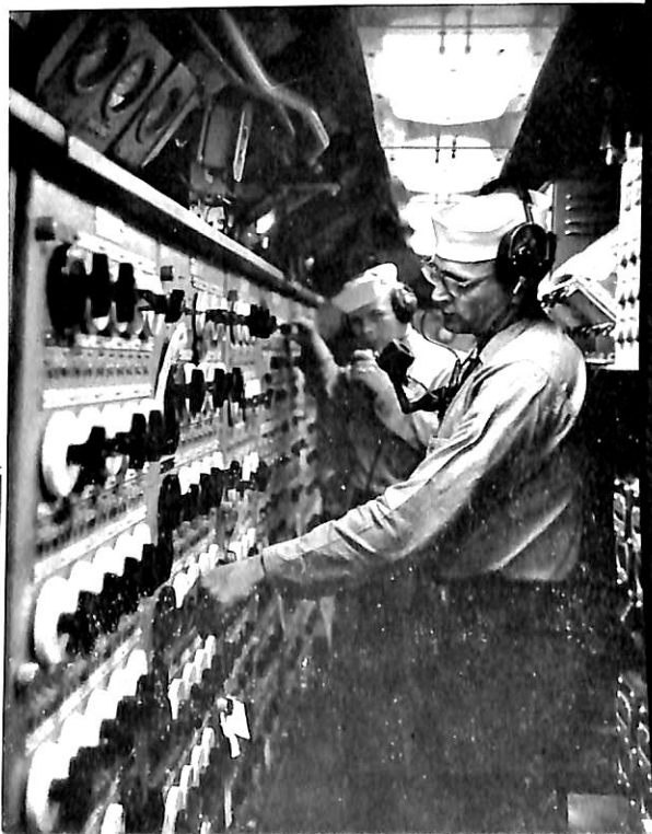
巨大な750ボルト・アンペアの電力の配電盤
