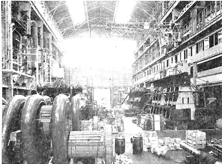
三井造船の大型ディーゼル機関組立工場
