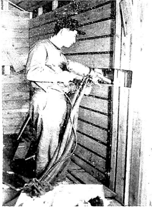
写真2 現場注入のようす
