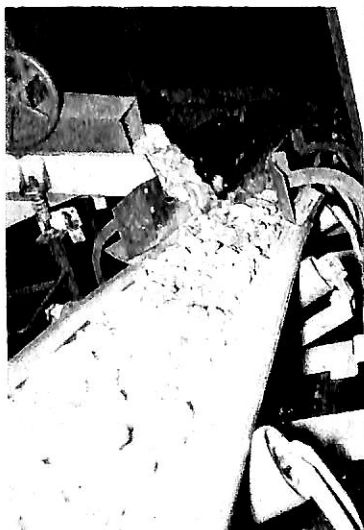
船底コンベヤーおよびフィーダー
