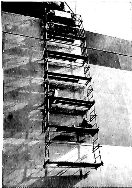
ビテイ式安全パイプ 移動式吊足場
