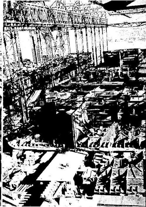
起工後3ヶ月の状況 (35-2-1)
