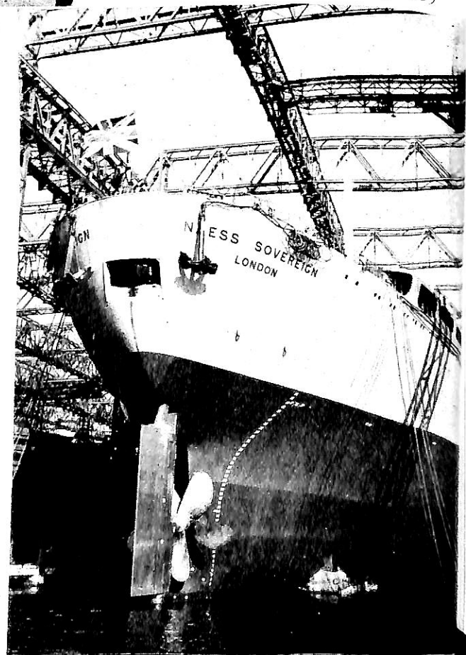
起工後5.5ヶ月の状況(先方)[第3船台ぶるっくりん丸(4月15日進水)第4船台 Philippine Leyte (6月11日進水)] プロペラ取付作業
