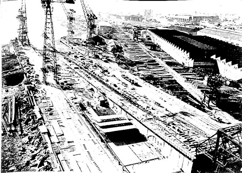
FRANCE の建造船台 キール盤木の整備すゝむ
