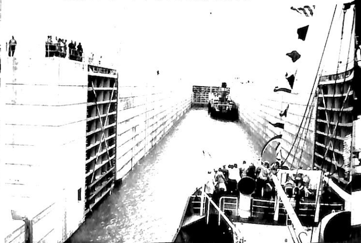
⑥ セント・ローレンス運河のスネル・ロック中の船舶。今回の開発工事により各ロックは同時に小型航洋船2隻を処理することができるようになった。これは運河通航のスピードアップに貢献しよう。
