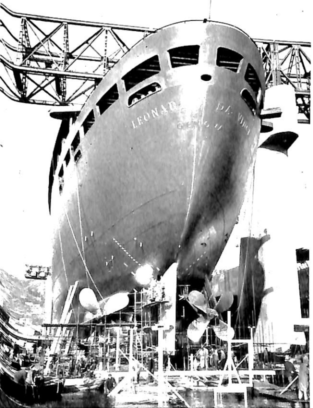
船尾部と進水台設備作業 (1958-12-3)
