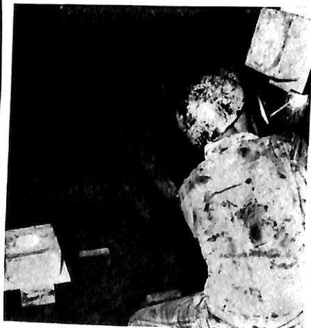
油槽船船槽に取付中の Mg 陽極 15S
